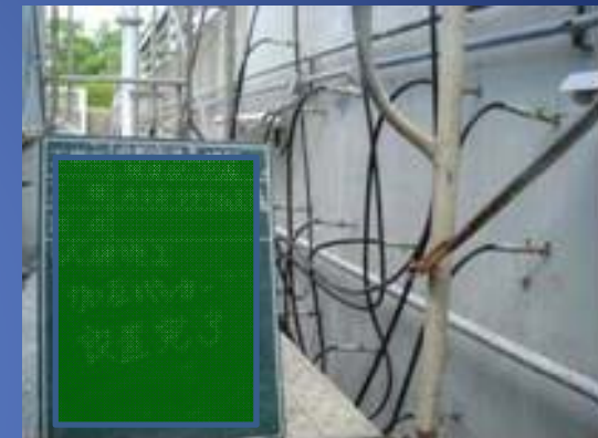
A施設内擁壁
