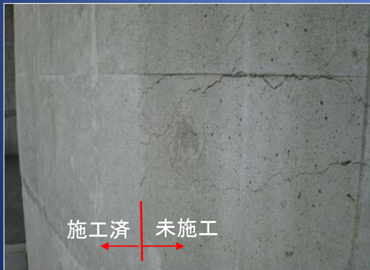
施工境界付近の状況
