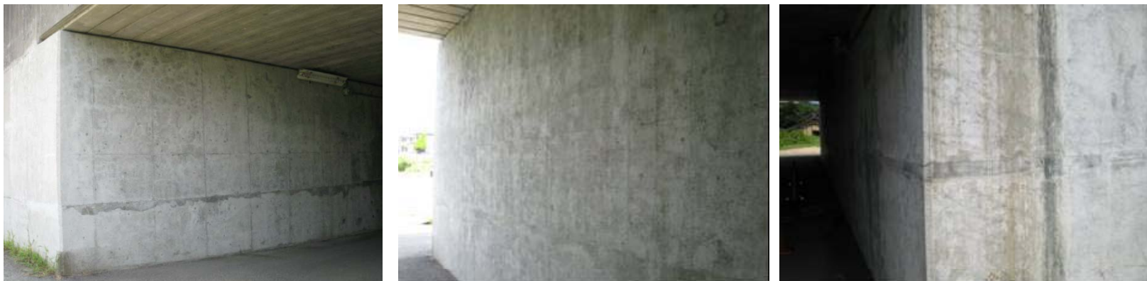
【施工後5年経過(2009年8月撮影)】
