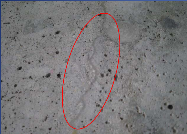
ひび割れ注入跡の状況
