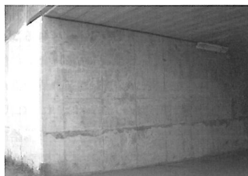
写真-2 陶橋—施工後4年経過した外観状況
