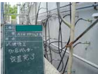
擁壁のASR補修事例
