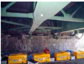
橋台のASR補修事例
