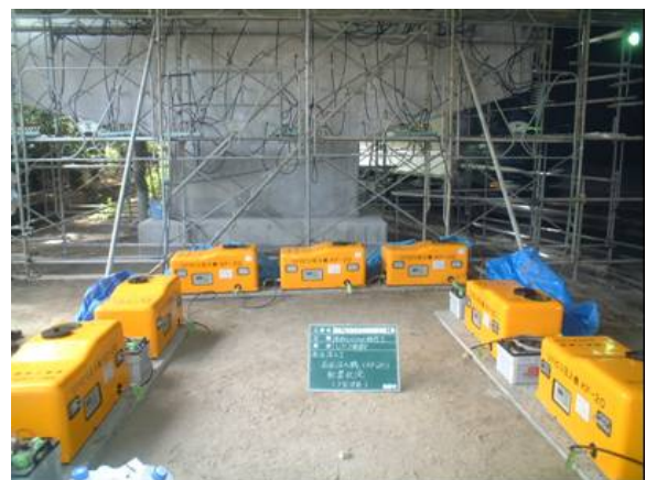
図-2 内部圧入工の施工状況
