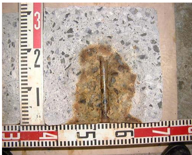
呈色反応試験による浸透状況確認
