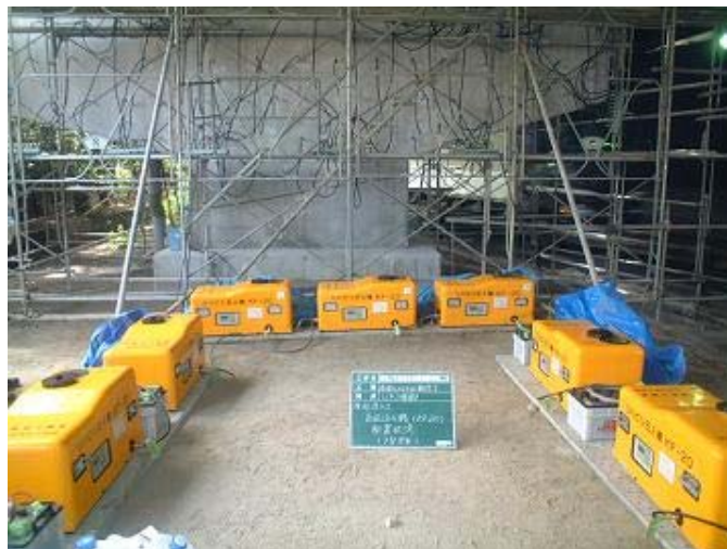
リチウム内部圧入(ASRリチウム工法)施工状況
