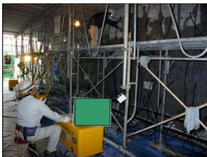
プロコン40を用いたリチウムイオン内部圧入施工状況
