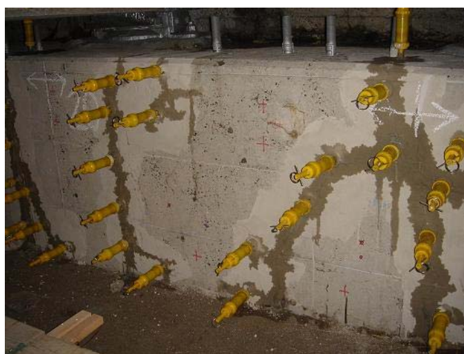
プロコン40を用いたひび割れ注入施工状況
