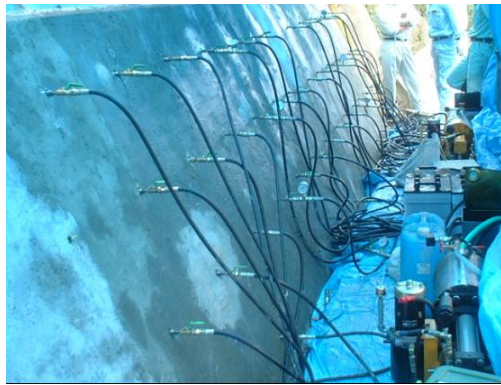
写真-1 日御碕擁壁施工状況
