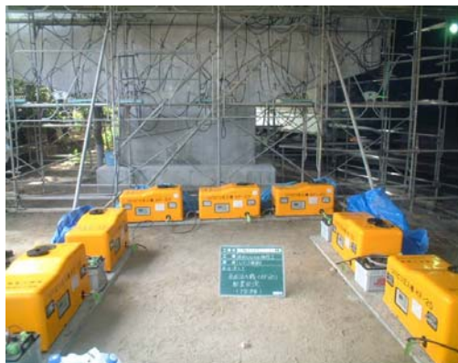
写真-2 海田高架橋施工状況
