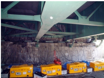
橋台のASR補修事例
