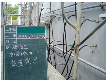
擁壁のASR補修事例
