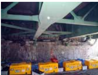
橋台のASR補修事例
