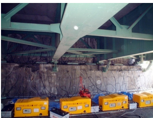
橋台のASR補修事例
