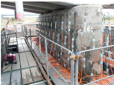
リハビリカプセル工法施工状況
