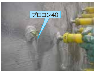
プロコン40先行注入の状況
