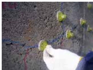
座金設置状況
