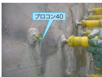
プロコン40先行注入の状況
