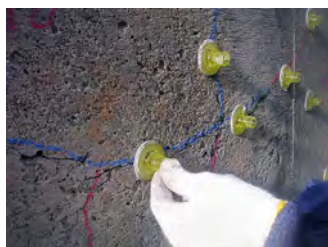
座金設置状況
